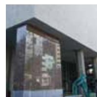
東洋文庫新本館の工事現場
